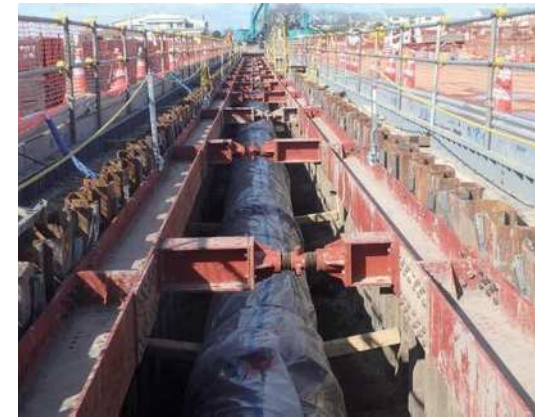
管路布設状況
