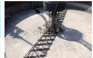
大久保浄水場汚泥調整池 (あと施工せん断補強)
