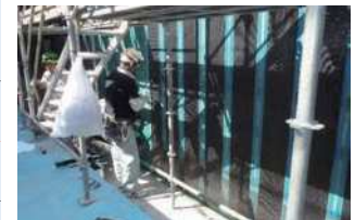
新三郷浄水場薬品沈でん池
