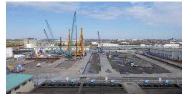
大久保浄水場高度浄水処理施設の工事状況
