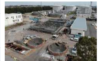
行田浄水場着水井
