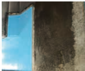
完成(青部分)の様子
