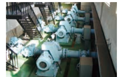
柿木浄水場の1系配水ポンプ (インバータ制御へ更新予定)
