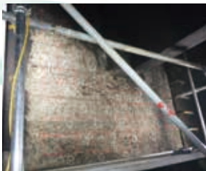
施工前の様子
