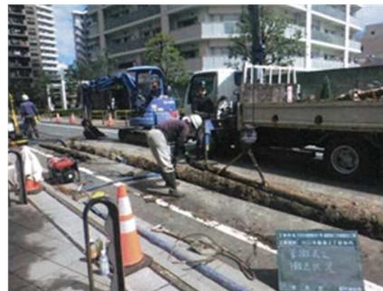
写真 3 不使用管撤去の様子
