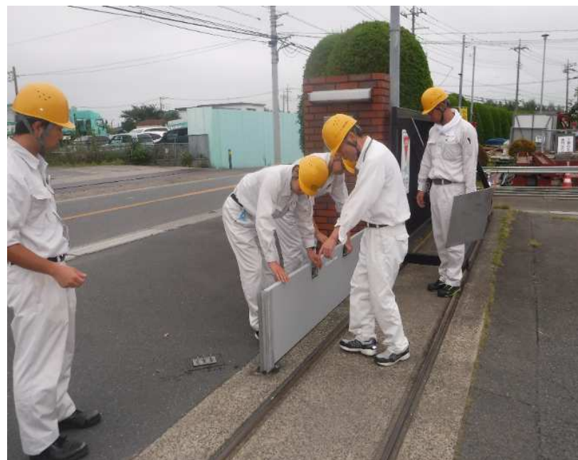
写真5 浸水害を想定した対応訓練（止水板の設置）
