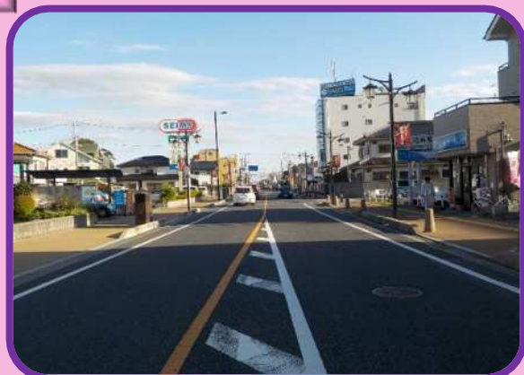
(都) 仲仙道 (北本工区) 拡幅及び電線共同溝の完了区間
