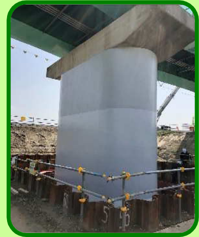
【耐震補強の一例】 (主) 鴻巣川島線 (糠田橋)
