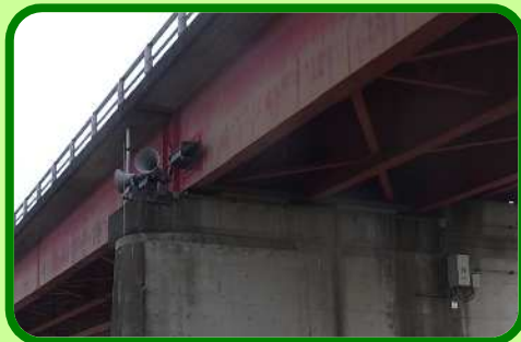
御成橋の塗替え (施工前)
