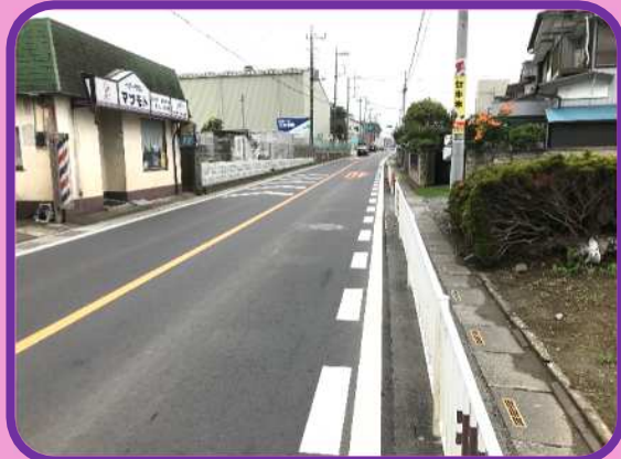
下石戸上菖蒲線 (宮内工区)
