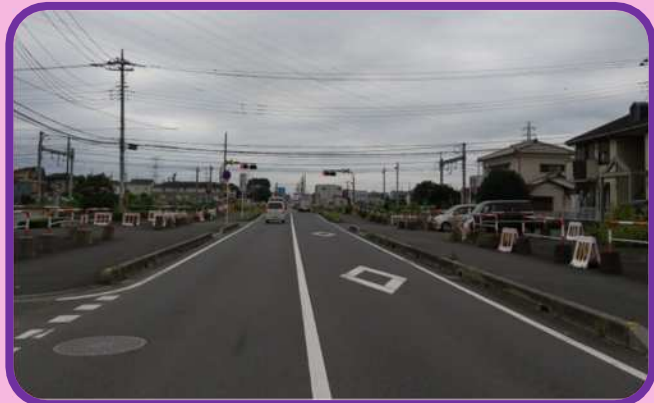
鴻巣川島線 JR高崎線の踏切付近
