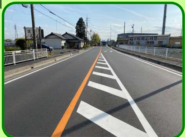
舗装の修繕 (施工後)
