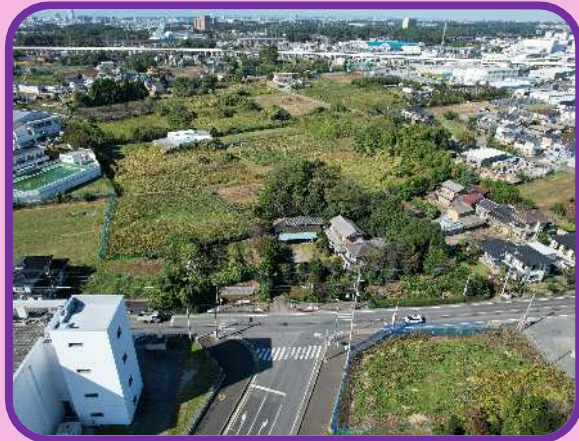
蓮田鴻巣線（小室工区）
