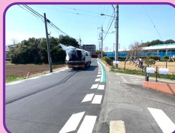
上尾環状線(小室工区)
