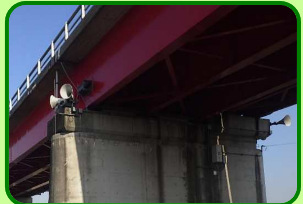
御成橋の塗替え (施工後)
