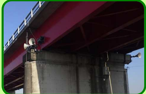
御成橋の塗替え後
