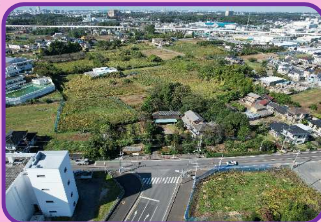
蓮田鴻巣線（小室工区）
