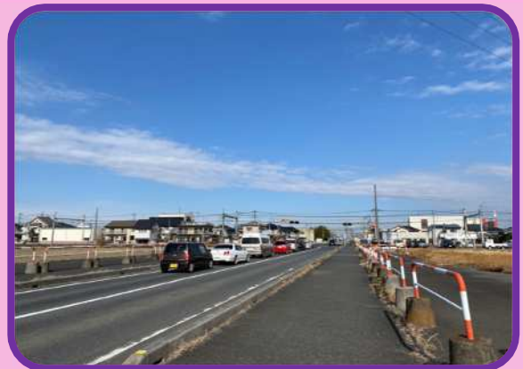
鴻巣川島線 JR高崎線の踏切付近
