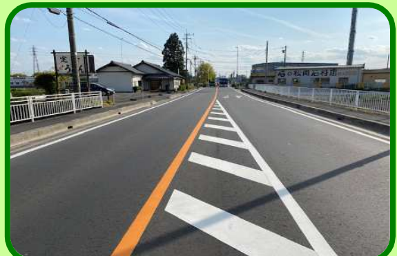
舗装の修繕後
