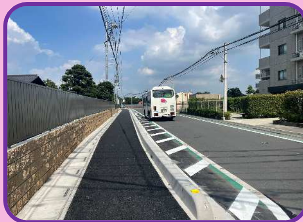
上尾環状線（小室工区）
