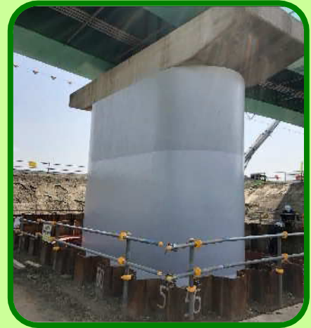
【耐震補強の例】 鴻巣川島線（糠田橋）
