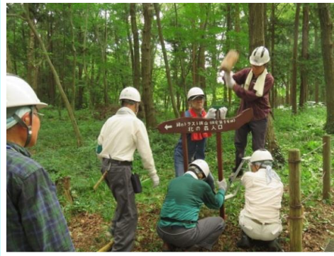
案内板設置作業 仁後 文晃 9号地
