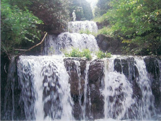
3段の階段状堰堤。
