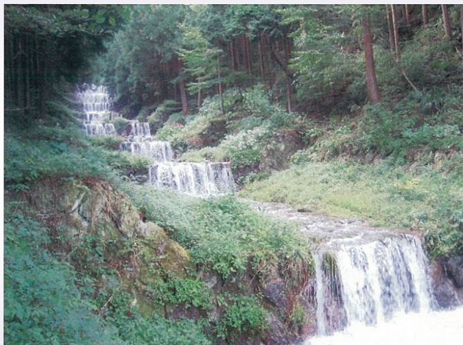
周辺環境と馴染んで一体化した状態で、階段状堰堤による緩傾斜化により安定した流路を形成している。
