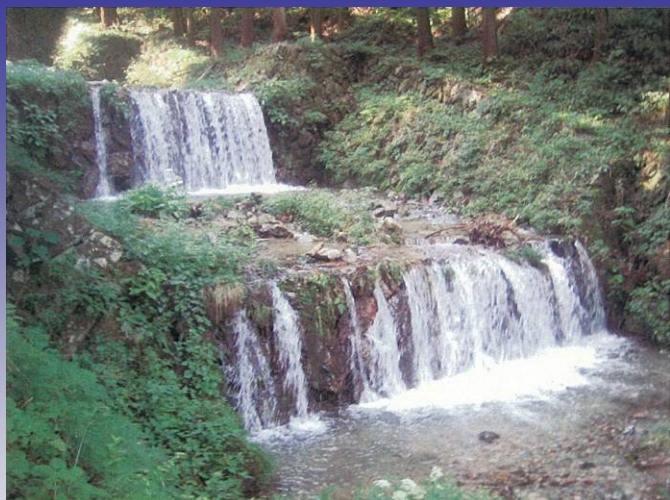
階段状堰堤は、堰堤、護岸工、護床工との組合せで構成されている。全て石積み。
