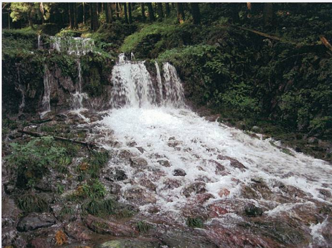
周辺環境と馴染んで一体化した状態で、階段状堰堤による緩傾斜化により安定した流路を形成している。
