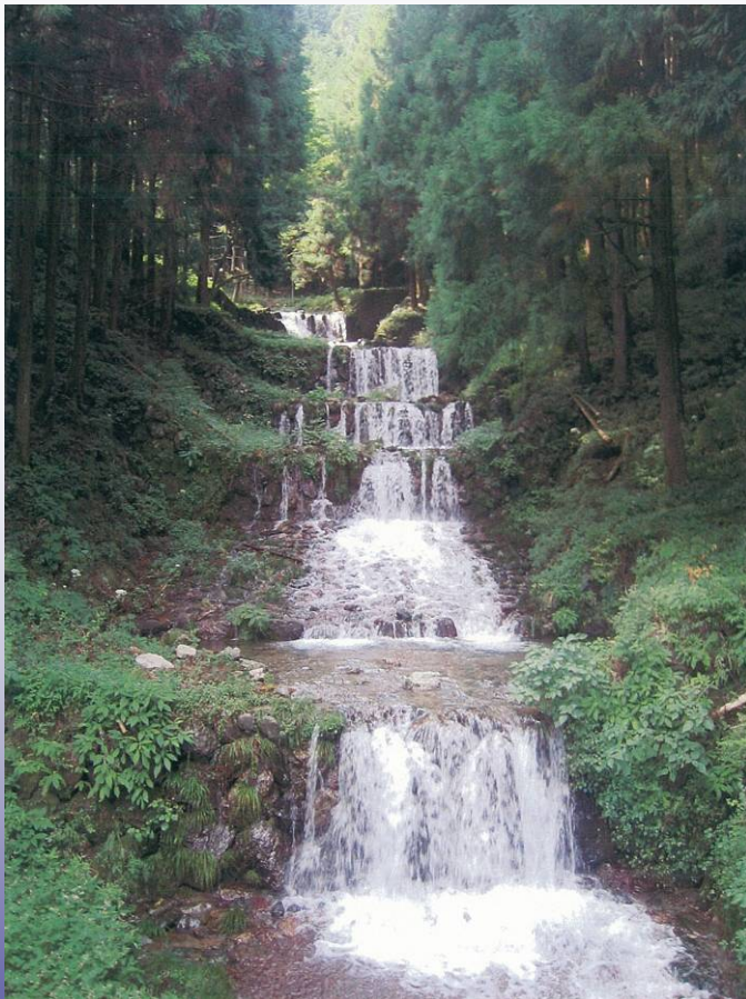
溪流の蛇行部までに6基の階段状堰堤が続く。
