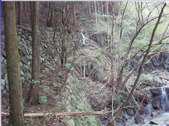
階段状堰堤の護岸は、堰堤間の変曲点の多い細かな取り合わせがなされている。また、多段積に施工され、山腹工と併用される箇所もある。
