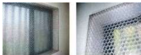
断熱シートの取り付け例
