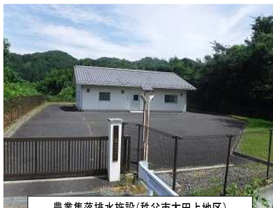
農業集落排水施設(秩父市太田上地区)
