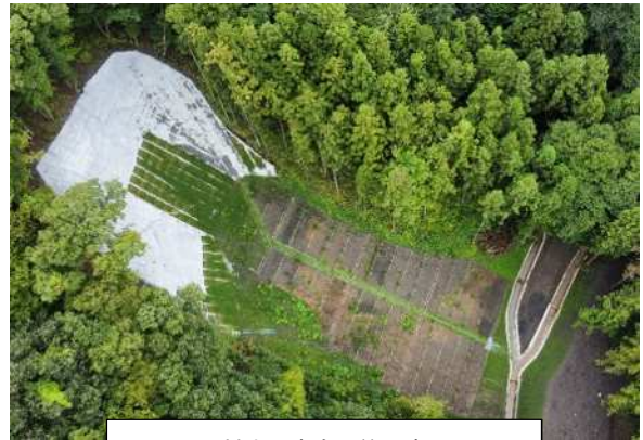
田の沢山村生活安全対策工事(秩父市)
