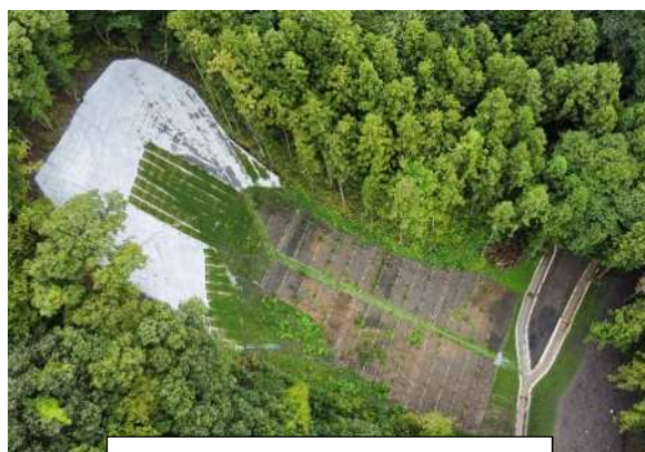
田の沢山村生活安全対策工事(秩父市)
