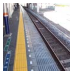
内方線付き点状ブロック
