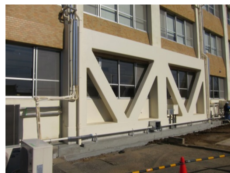
耐震補強を行った飯能合同庁舎
