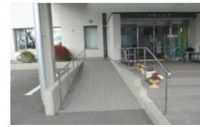
出入口の段差解消 事業費：30万円程度
