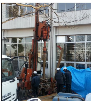
掘削中の様子
