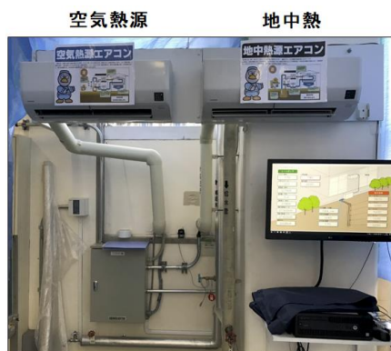
図4 地中熱実証試験システムの設置
