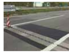
〈施工例（橋梁ジョイント部の段差修正）〉
