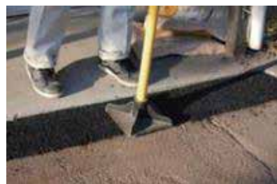
上から転圧します
