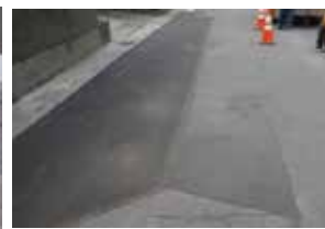
施工例 路面凹凸の平滑化
