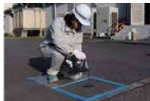
混合したものを均して均します
