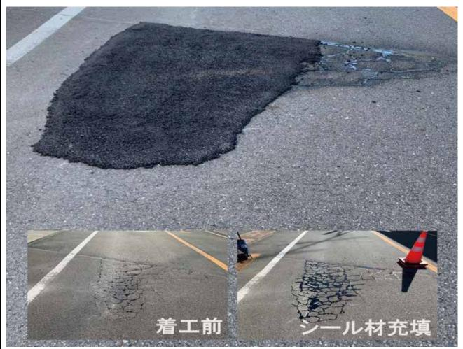
SA パーマネントパッチ 袋/10 kg シール材(スーパーフレックス) \_\_\_\_\_\_ <施工年度> 令和元年度
