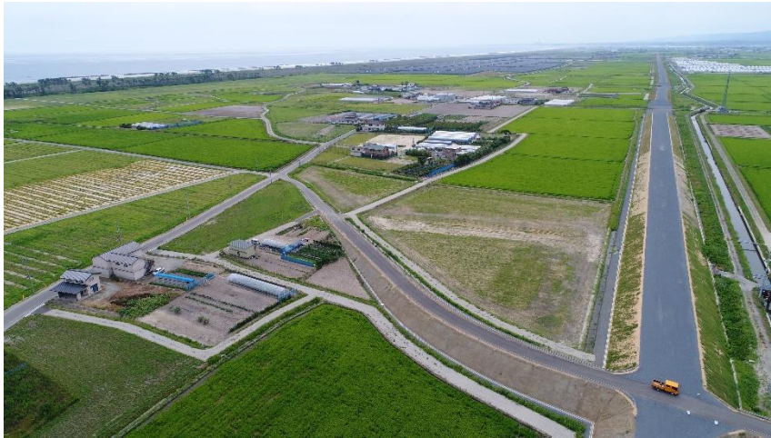
二線堤（写真右側）と太平洋（写真左上部）
