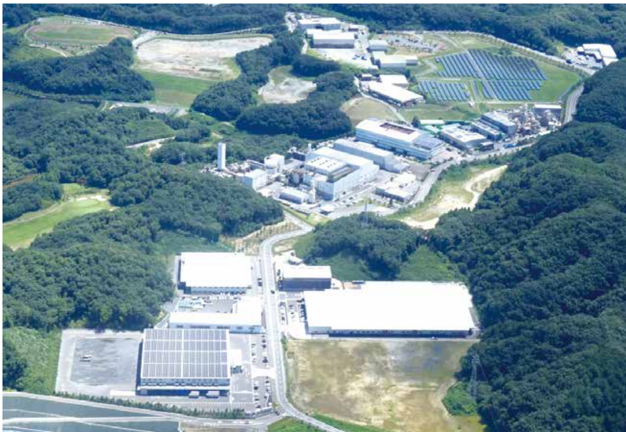
写真4-2 彩の国資源循環工場
