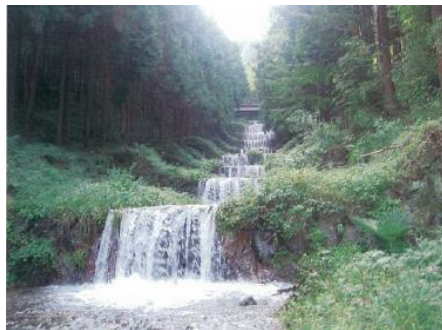
七重川砂防堰堤(県ホームページより)
