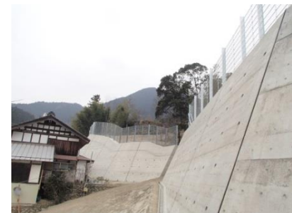
急傾斜地崩壊対策施設
