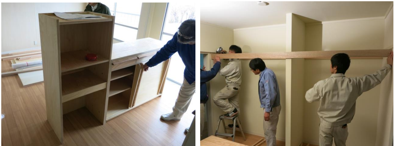
学生による改修状況（平成26年度の実施状況）
