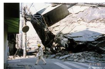
阪神・淡路大震災 出典:(財)消防科学総合センター
