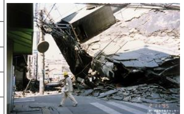
阪神・淡路大震災 出典：(一財)消防防災科学センター
