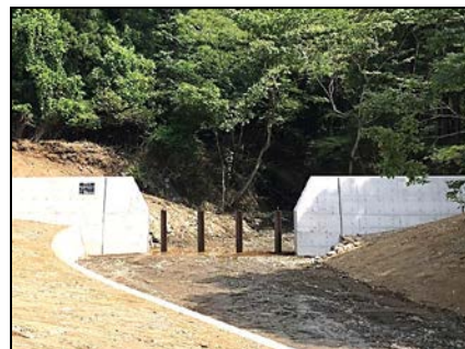
治山施設の設置
