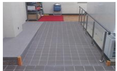
スロープ設置
