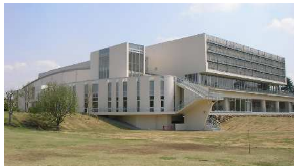
【体育館】平成19年5月に開館した和光市総合体育館
