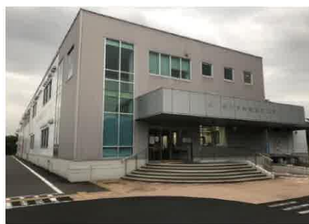
鶴ヶ島市学校給食センター
