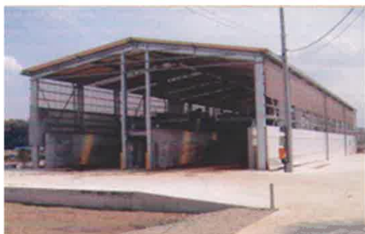
第二工場(堆肥切り返し工場)
