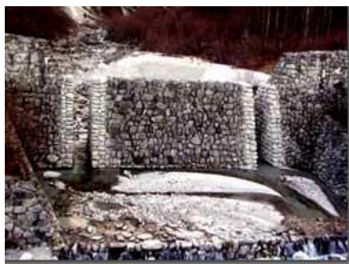
写真Ⅱ- 3-1 コンクリートスリット砂防堰堤
