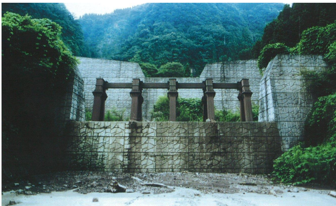
写真- 1 副堰堤流木止工
