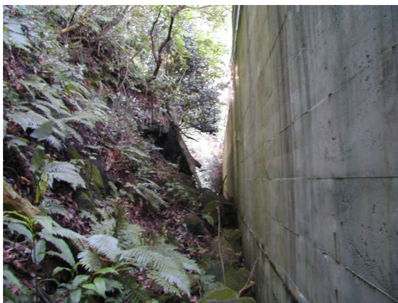
写真5 待受対策施設ポケット状況
