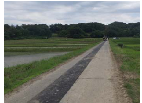
幹線パイプライン実施状況
