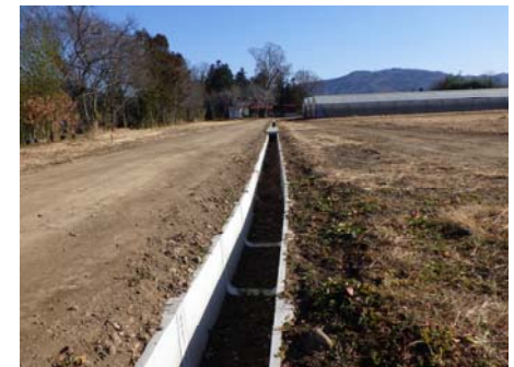
水路工完了状況
