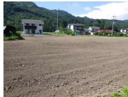
整地工完了状況
