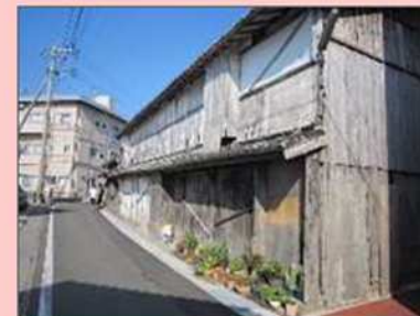
空き家の除却
