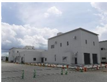
第二沈砂池ポンプ棟の築造
