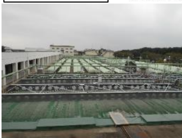
水処理3系列が稼働
