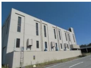
沈砂池ポンプ棟 耐震化を予定
