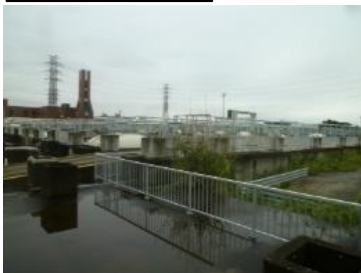
水処理施設(新河岸川水循環センター) 5系列が稼働
