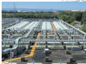
水処理3.5系列が稼働 6-2系を増築
