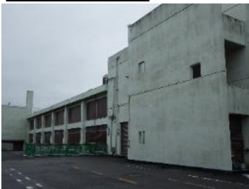
沈砂池ポンプ棟 耐震化のため再構築を実施
