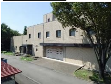
機械棟 耐震化を予定
