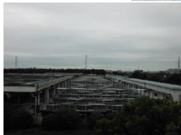
水処理9系列が稼働
