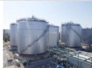
消化槽9,000m 3 ×4基 汚泥減容化とバイオガス活用
