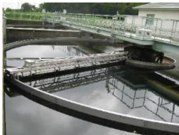
水処理3系列が稼働 4系を築造
