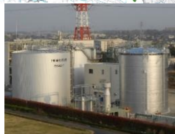
消化槽5,000m 3 ×3基 汚泥減容化とバイオガス活用
