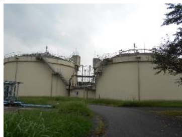
汚泥消化導入を検討 汚泥減容化とバイオガス活用
