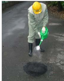
&lt;水溜りでの施工状況&gt;
