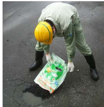
&lt;水溜りでの施工状況&gt;
