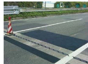
&lt;施工例(橋梁ジョイント部の段差修正)&gt;
