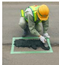
&lt;施工状況&gt;
