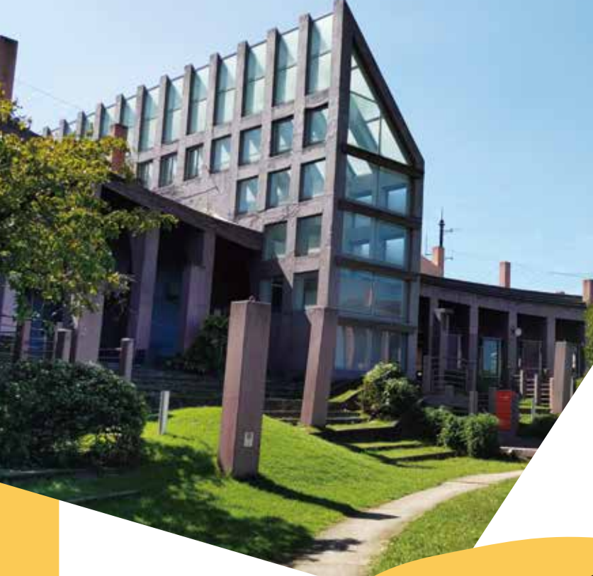
コミュニティセンター 進修館
