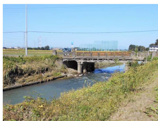
橋りょう架換え工事 県道騎西鴻巣線(青柳橋)
