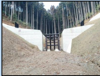
砂防えん堤工／慈光寺川地区
