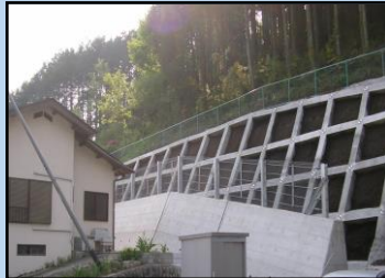
急傾斜地崩壊対策工／細入地区
