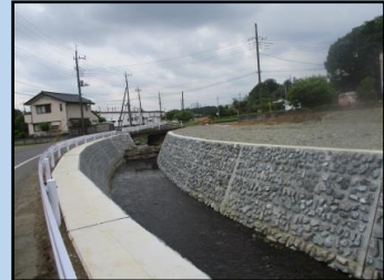
溪流保全工／南小畔川
