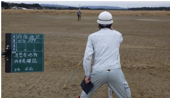
工事の監督の様子
