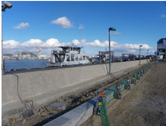
塩竈港棧橋の防潮堤の嵩上げ工事
