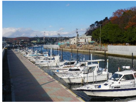
塩竈貞山運河の防潮堤工事
