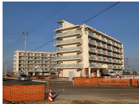
④完成した災害公営住宅 (H29.10月)
