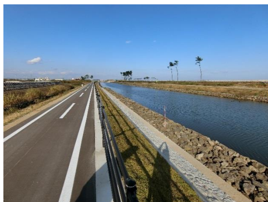
① 貞山運河の復旧状況(H29.10月)
