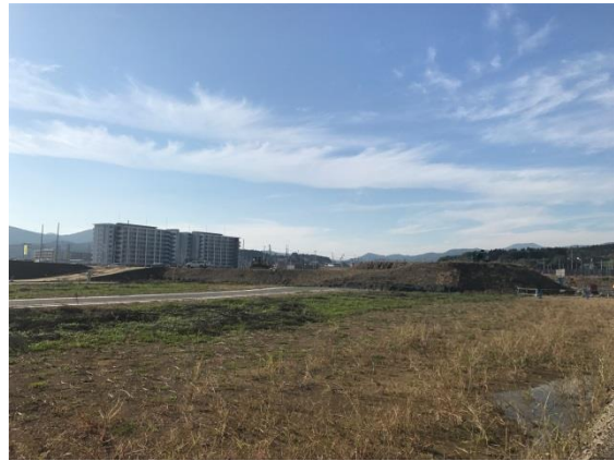
気仙沼市嵩上げ工事の様子
