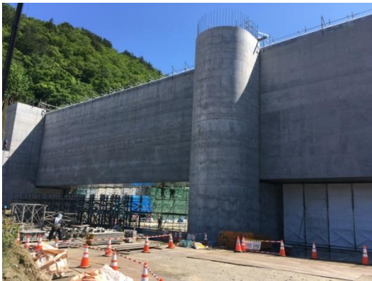
建設中の防潮堤
