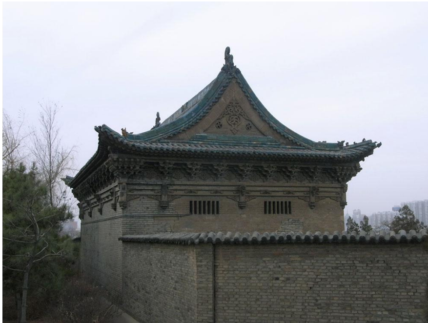
双塔寺の一部。壁はレンガ造り、屋根は三彩の瓦で葺かれています。
