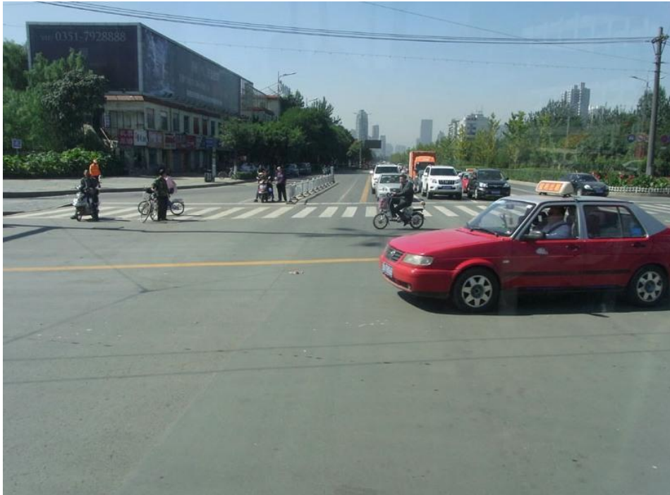
中心街に向かう途中の道路。片側6車線あります。
