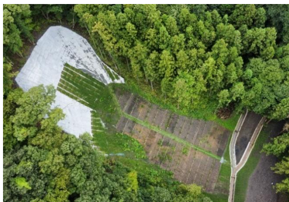
治山事業による安全対策
