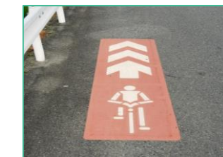
▲道路着色舗装
