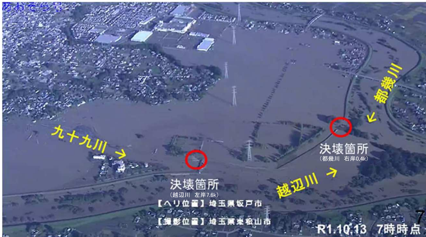
■越辺川、都幾川堤防決壊箇所の洪水直後の状況
