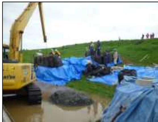
北上川下流河川事務所による大型土のうを使用した月の輪工
