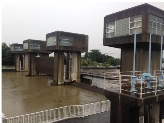
耐震対策が必要な頭首工（古利根堰・越谷市、松伏町）
